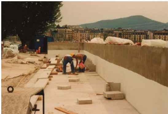
Fig. 133. Réparation dalles toiture
